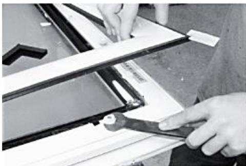
2. Ôter le cadre aluminium et repérer le positionnement des cales de vitrage afin de les remettre aux mêmes emplacements.
