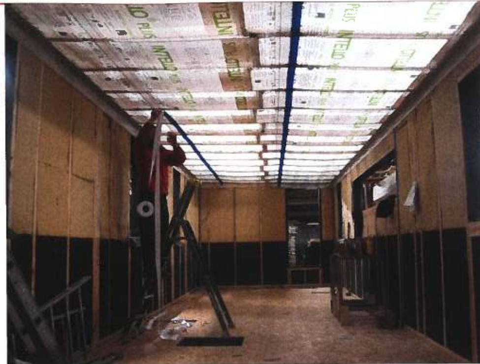
Puis assemblage de l'habitation avec isolation en liège sur 1,20 m, suivie par du Mébisse en 220 mm.
