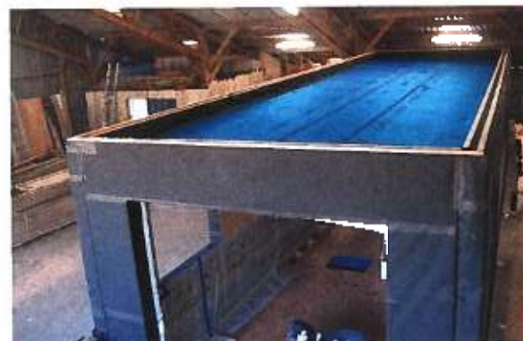
La toiture est traitée comme celle d'une maison avec une membrane EPDM.
