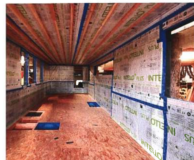
été à l'air est soignée, l'intégralité des murs et de la toiture est recouverte d'un leur hygrovariable Intello.
