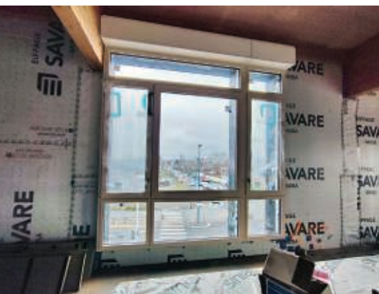
La protection solaire dans les salles de classe, le réfectoire et la bibliothèque est assurée par des volets roulants à coffre intérieur pour faciliter l'accès et les réparations éventuelles.
