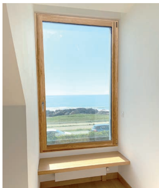
Le concept de fenêtre Hybride VEC et bambou signé Minco. © Minco.
