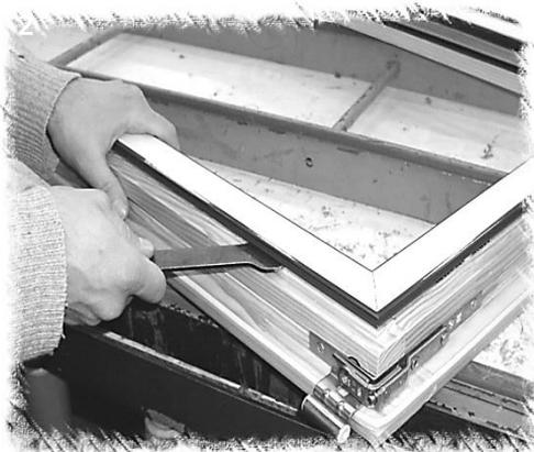
Ôter le cadre aluminium et repérer le positionnement des cales de vitrage afin de les remettre au mêmes emplacements.
