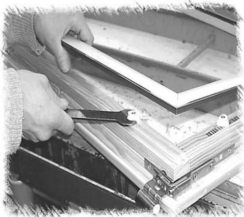
Mettre le vitrage en place puis les cales avec l'aide d'une main de bois. Poser le cadre aluminium et reverrouiller les plots.
