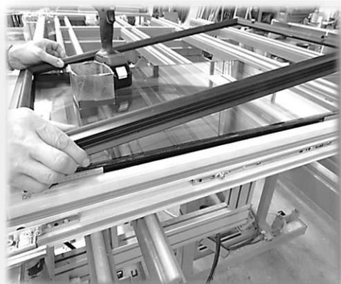
Mettre le nouveau vitrage en place puis les cales avec l'aide d'une main de bois. Poser le cadre ABS et revisser l'ensemble des vis noires.
