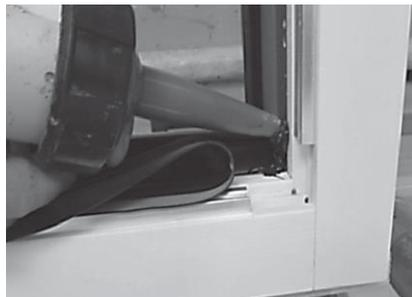
Découpe au ciseau de la membrane/joint pour pliage et recouvrement sur vitrage. Pliage et collage de la membrane avec l'adhésif sur le vitrage, en commençant par les 2 parties verticales et ensuite la partie horizontale en recouvrement dans les angles avec rajout de mastic Butyl.
