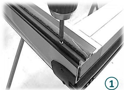
Retirer les vis de fixation du profil chicane alu. Sur la hauteur à côté du joint brosse.
