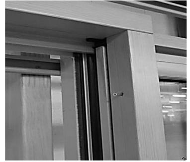
2. En partie haute, enlever les ponts d'étanchéité.
