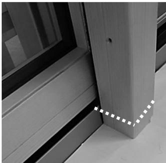
5. Mettre en place la butée dans le logement prévu à cet effet.
